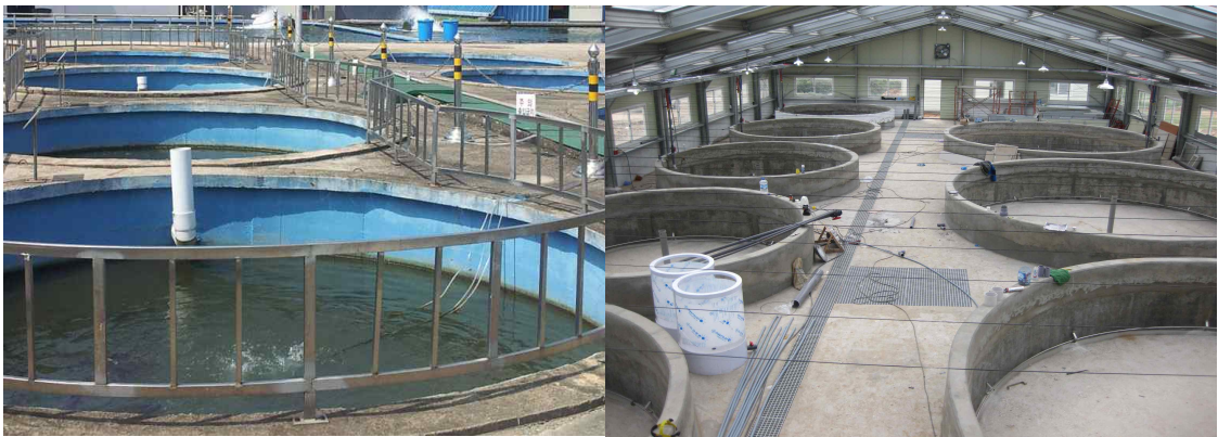
〈Fig〉 콘크리트 양식수조 모습
