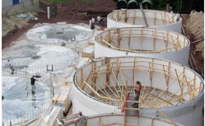
〈Fig〉 PVC-CP양식수조 제작모습
